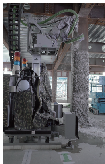
ハウスメーカーで施工現場へのロボットの導入が進む。画像は大和ハウス工業が実証実験を行った現場作業ロボット
