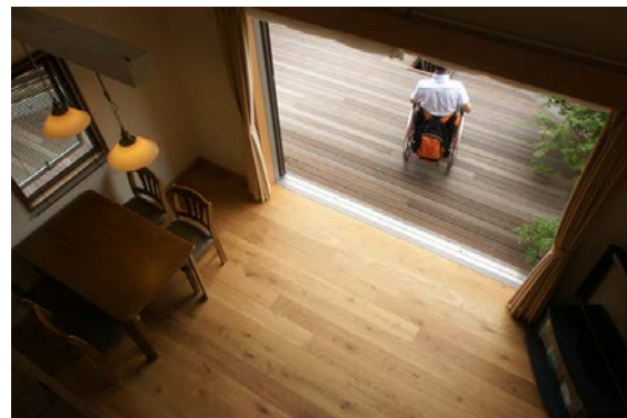
車いすの住まい手の例。バリアフリーサッシュをつけて庭のウッドデッキと居間を一体化。
