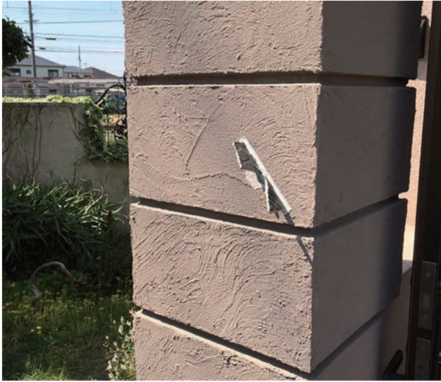
隣家の屋根が飛来し外壁に突き刺さった様子。被災を忘れないようにするため、現在も刺さったままにしている。
