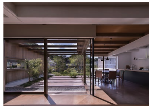
家の内外を間仕切る。木製ガラス片引き戸とFIXガラスを組合せている。引き戸を開けば大開口で、室内でも外にいるかのような開放感。ロール網戸を見た目にノイズにならないよう組み込んでいる。(撮影：森日出夫)
