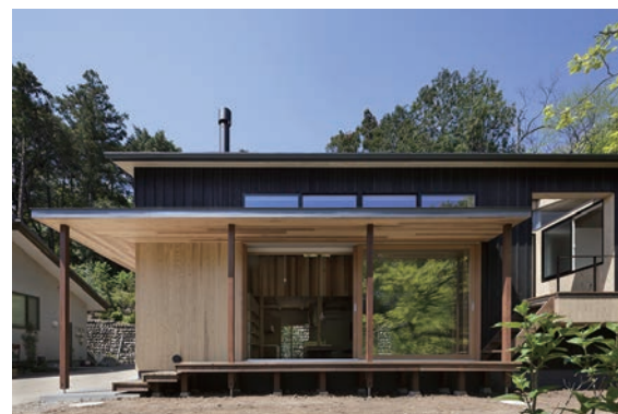
「森林公園の家」豊かな自然の恵みを大開口部から取り込み、家の内外を緩やかにつなぐ土間空間を設けています。
