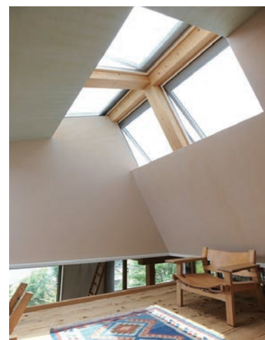
開閉式の天窓を採用した住宅事例。風の流れを考慮して、吹き抜けを利用することで外のように爽やかに風通しの良い明るい住まいが実現する。
