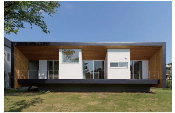
②S 邸：日射を制御する深い軒下空間
