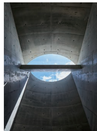
7m 高の天井最上部に円弧天窓がある
